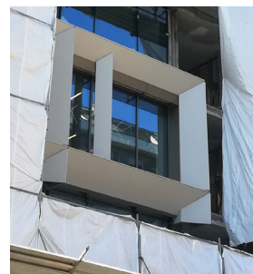
Esplosione assonometrica degli elementi di facciata e mockup in cantiere del rivestimento esterno
