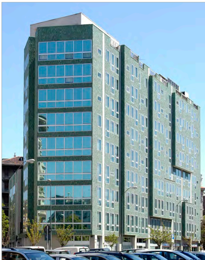
VISTA DELLA TESTATA TRA LE VIE DORIA E MACCHI DEL PALAZZO PER UFFICI MONTE DORIA (FOTO DI FEDERICO BALESTRINI)
