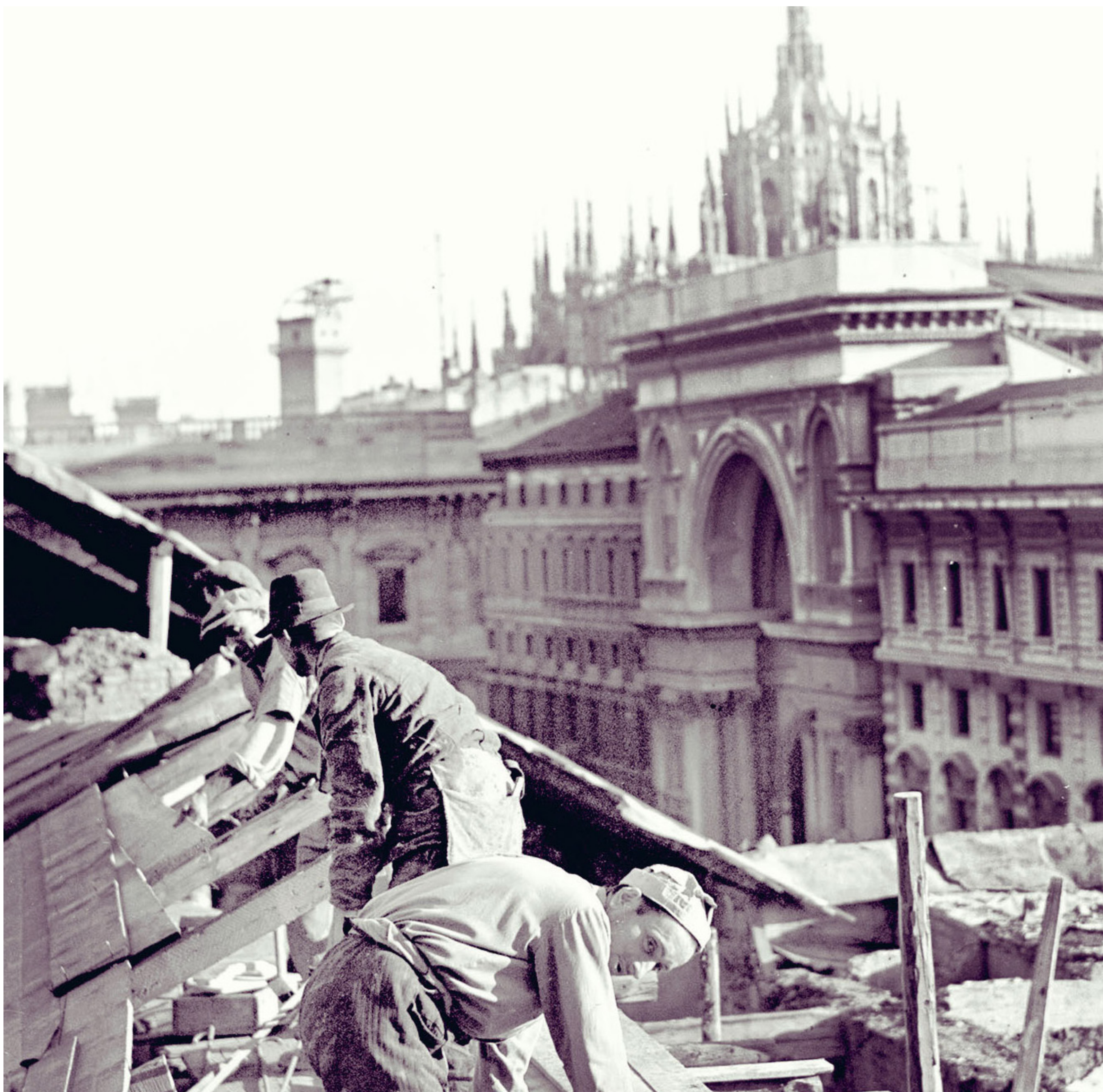
Operai lavorano sul tetto del Teatro alla Scala Dopo il bombardamento alleato (1943) © Istituto Luce / Gestione Archivi Alinari, Firenze
